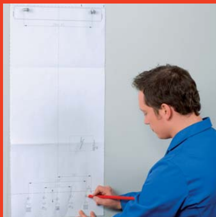
1 Přípravná montáž se šablonou
